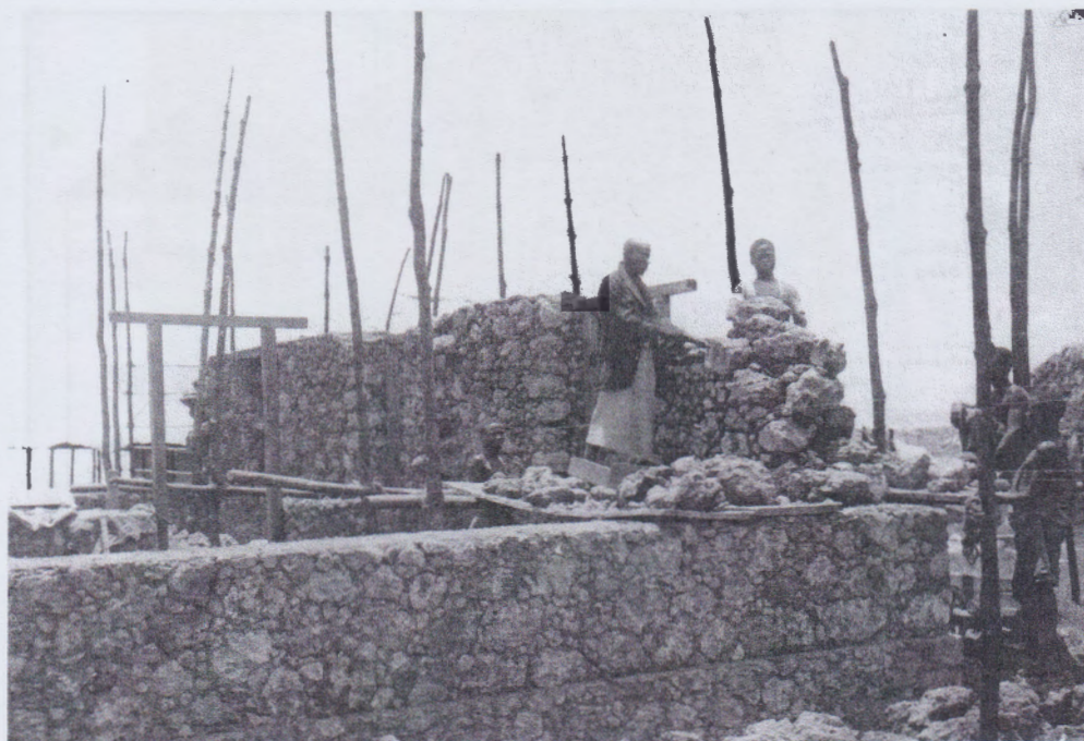
Abb. 3: Errichtung von Massenmauerwerk aus Korallenbruch Nachweis: Archiv des Instituts für Länderkunde, Leipzig.
