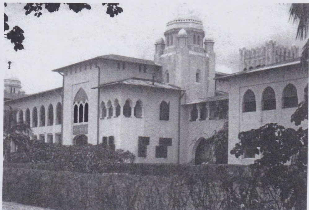
Abb. 13: Ansicht des deutschen Krankenhauses, Seeseite, in Dar-es-Salaam Nachweis: Archiv des Autors.
