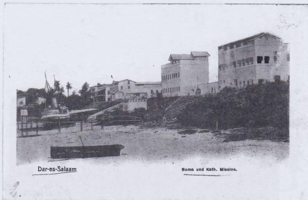
Abb. 7: Aufgesetzte Satteldächer auf arabischen Gebäuden in Dar-es-Salaam Nachweis: Archiv des Autors.
